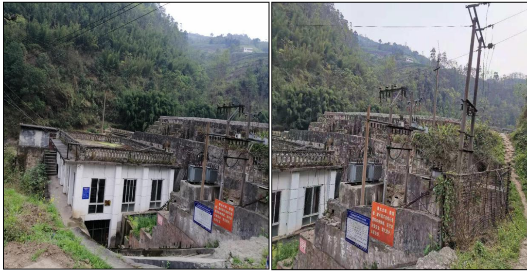
电站厂区及升压站周围生态植被恢复情况
