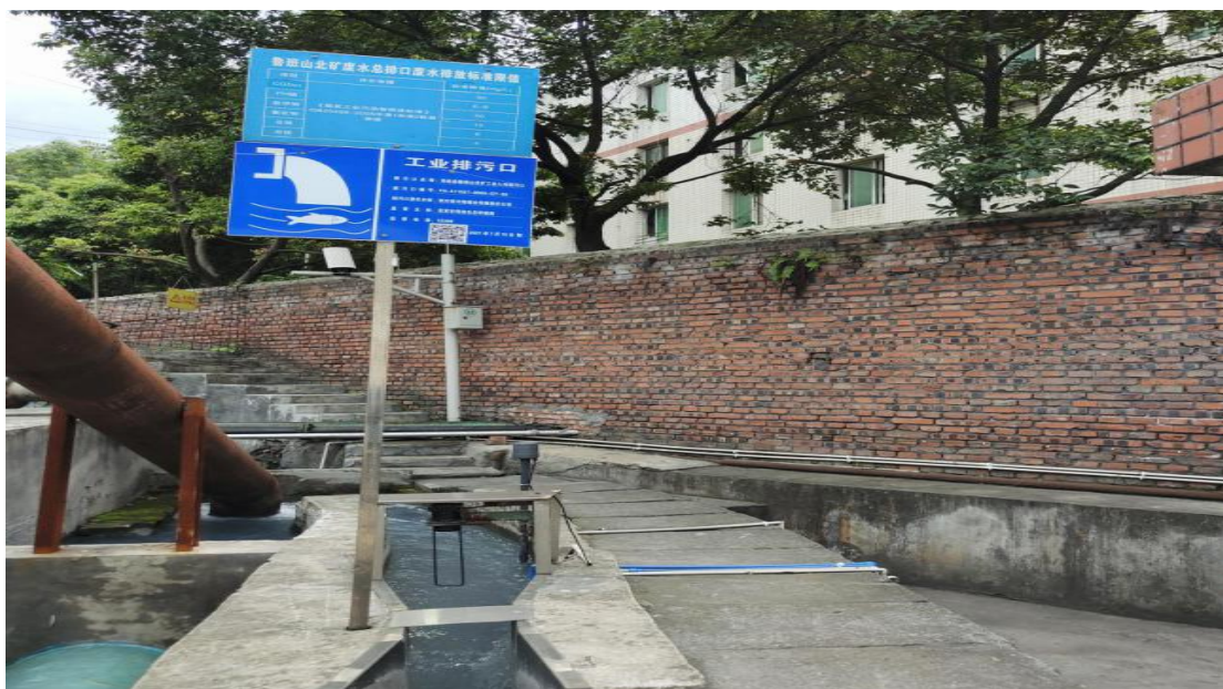
图 4-1 废水总排口出水渠及标示标牌
