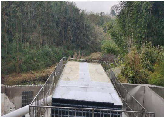
污水处理站池体密闭加盖
