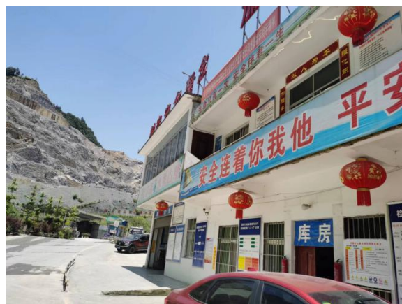
办公楼及食堂
