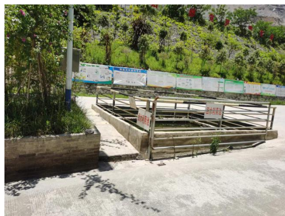
车辆冲洗水沉淀池
