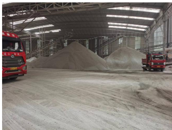
封闭式成品堆场
