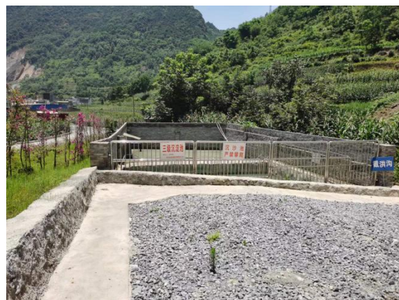
末端雨水收集池
