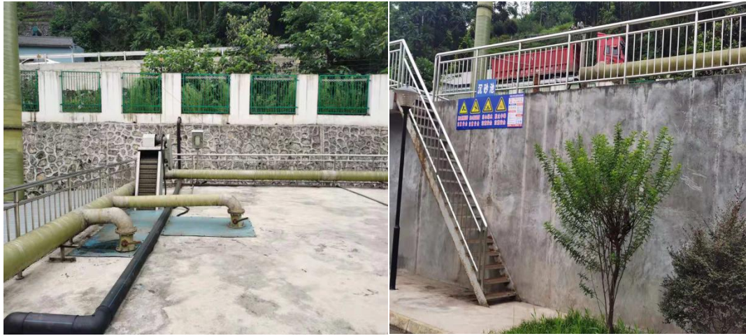
图 4-2 格栅沉砂池恶臭气体收集系统
