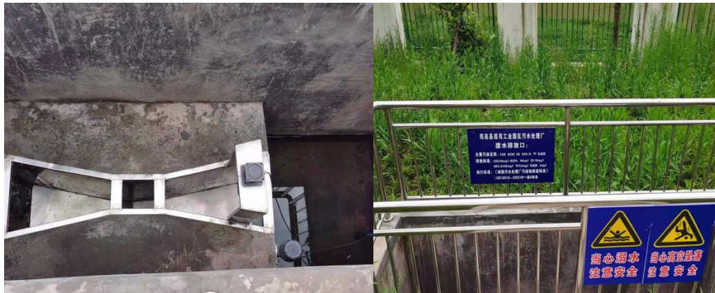
图 4-1 出水渠及废水排放口标示
